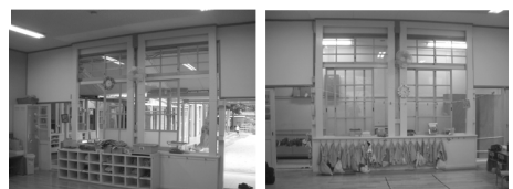
写真2 保育室のリブフレームによる補強
