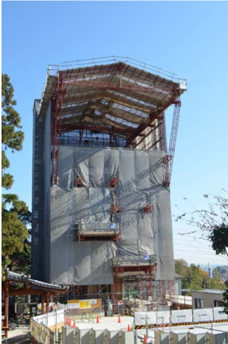
【素屋根の様子】
