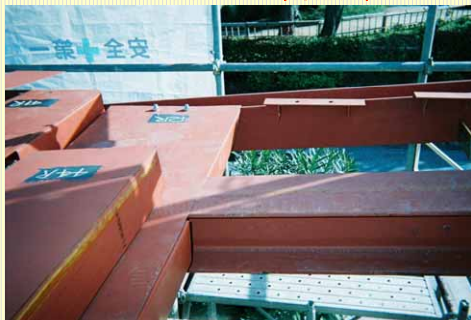
鋼板ピース(出隅部分)
